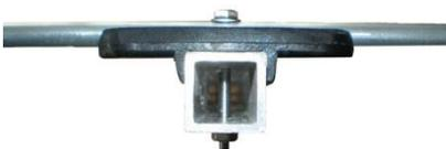
An den Markierungen für die Bohrlöcher (nur Reflektor und Direktoren) bohren Sie 3,5mm bzw. 4,5mm Locher, je nach Schraubendurchmesser, mittig in den Boom. Das Element wird dann wie abgebildet auf dem Boom montiert.
